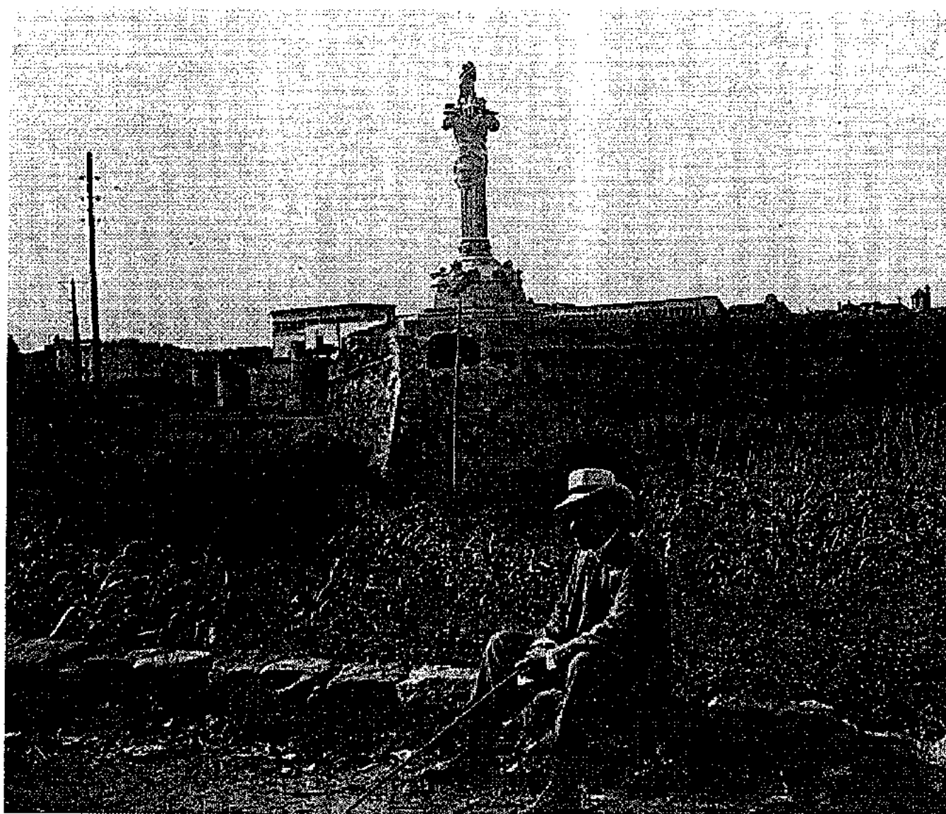
Imatge 60. El baluard de Sant Francesc, futura plaça del Lleó.
