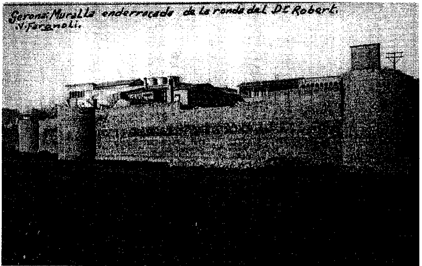
Imatge 19. L'inici de l'enderroc de la muralla est, futura Gran Via.
