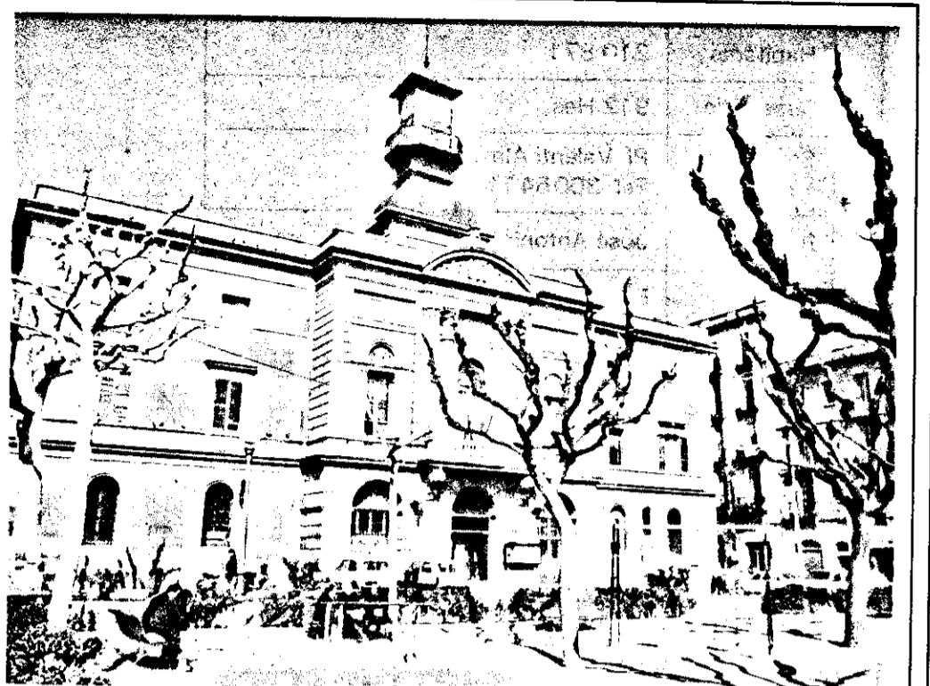
El vell edifici de la plaça Valentí Almirall tornarà a ser com un petit ajuntament per als habitants del nou districte. Un districte del qual, en aquest número especial del "Full Informatiu", oferim una àmplia informació amb mapes, història, guies de serveis, etc.
