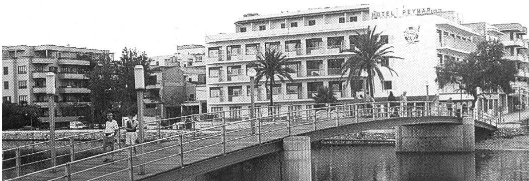
Els efectes del “boom” turístic: Les instal·lacions hoteleres a nuclis de vorera de mar com S'Illot es varen multiplicar a partir dels anys seixanta. Foto: GEM
