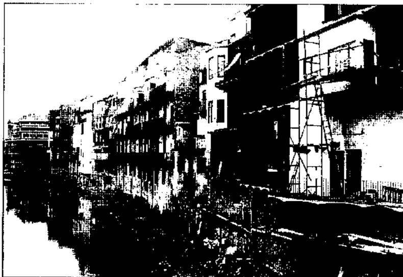
Les façanes de la banda dreta del Ter al seu pas per Ripoll han canviat completament d'aspecte. Foto: J.C.
