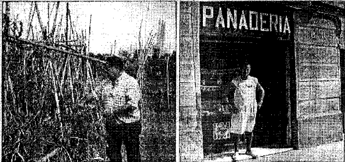
L'ALTRA MINA. La Mina de los molinos
