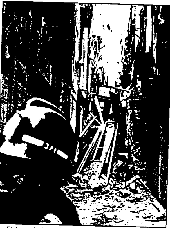
El derrumbe impidió que se transitara por la calle Tarròs
